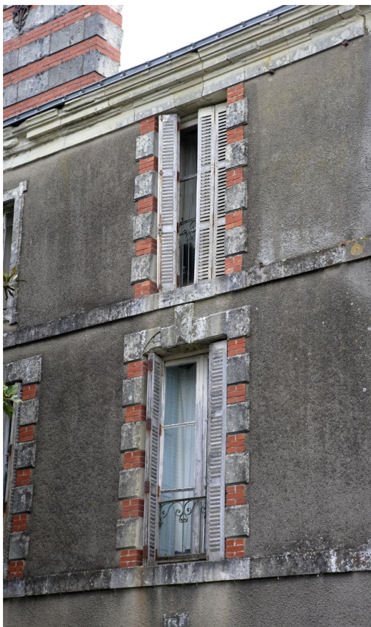
Détail des ouvertures du bâtiment administratif construit en 1911.
