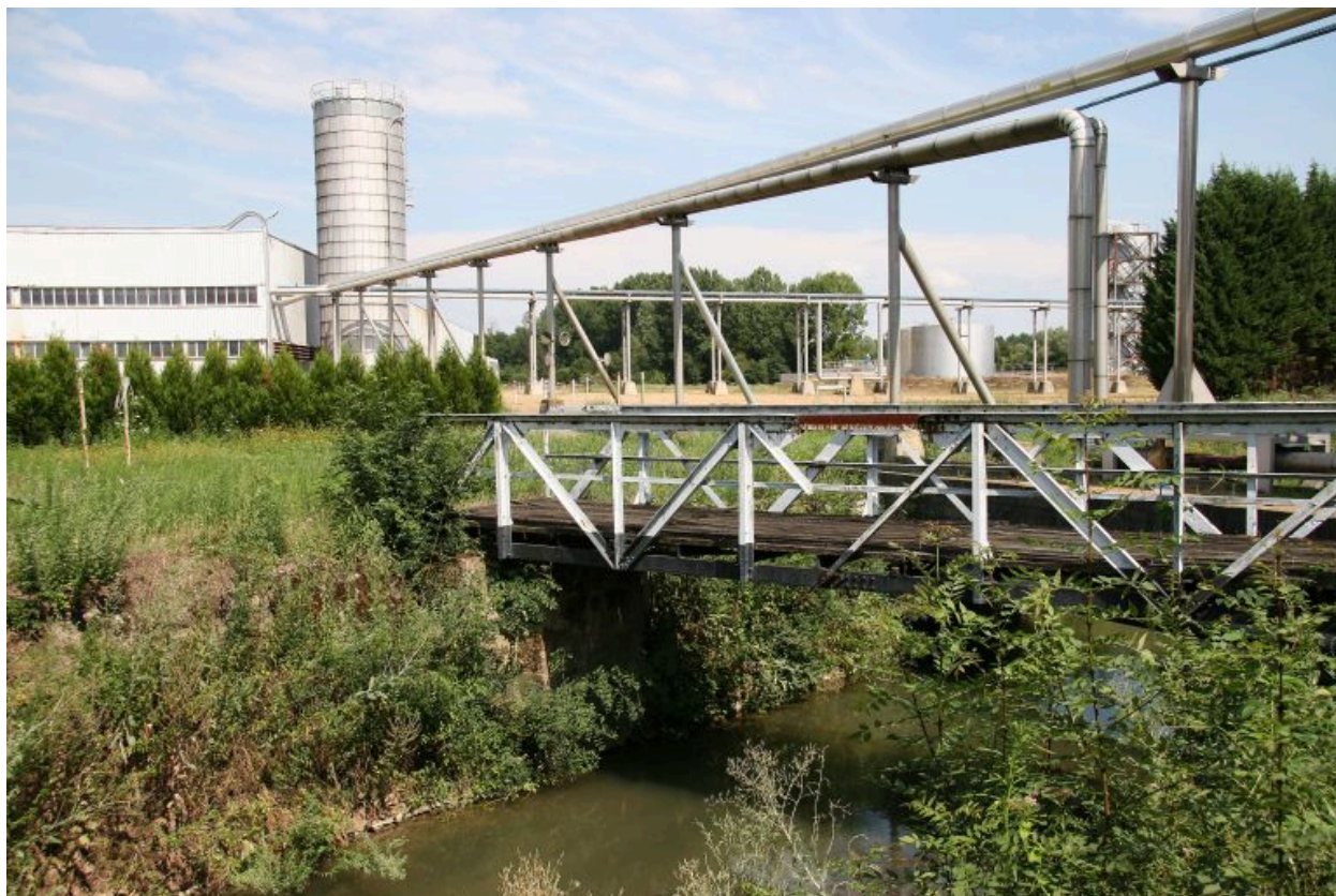
Pont en fer sur la boire.
