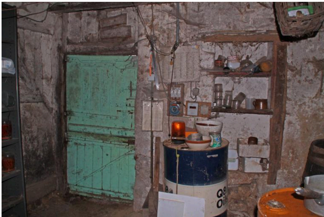
Chambre à feu : structure en bois et pan de bois.
