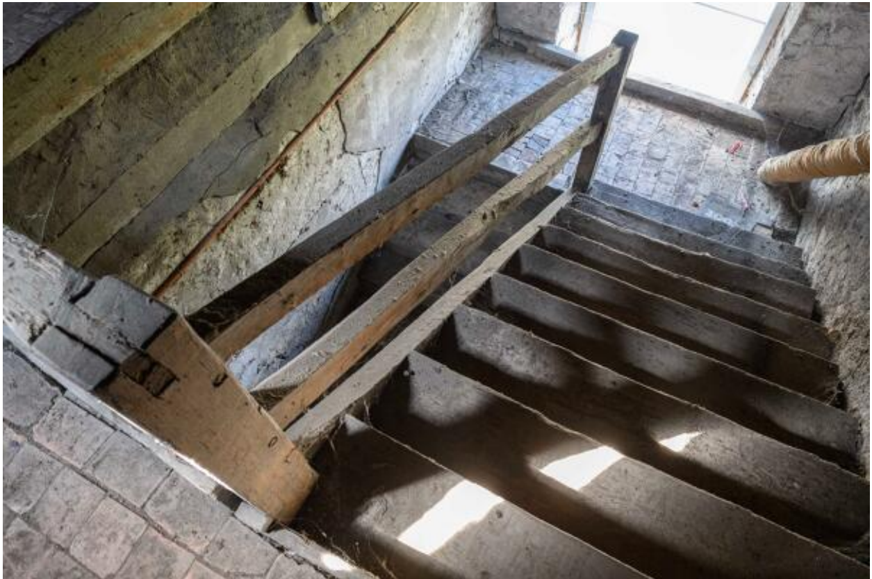
Vue d'ensemble de l'escalier menant au comble, Petit Château, Montjean-sur-Loire.
