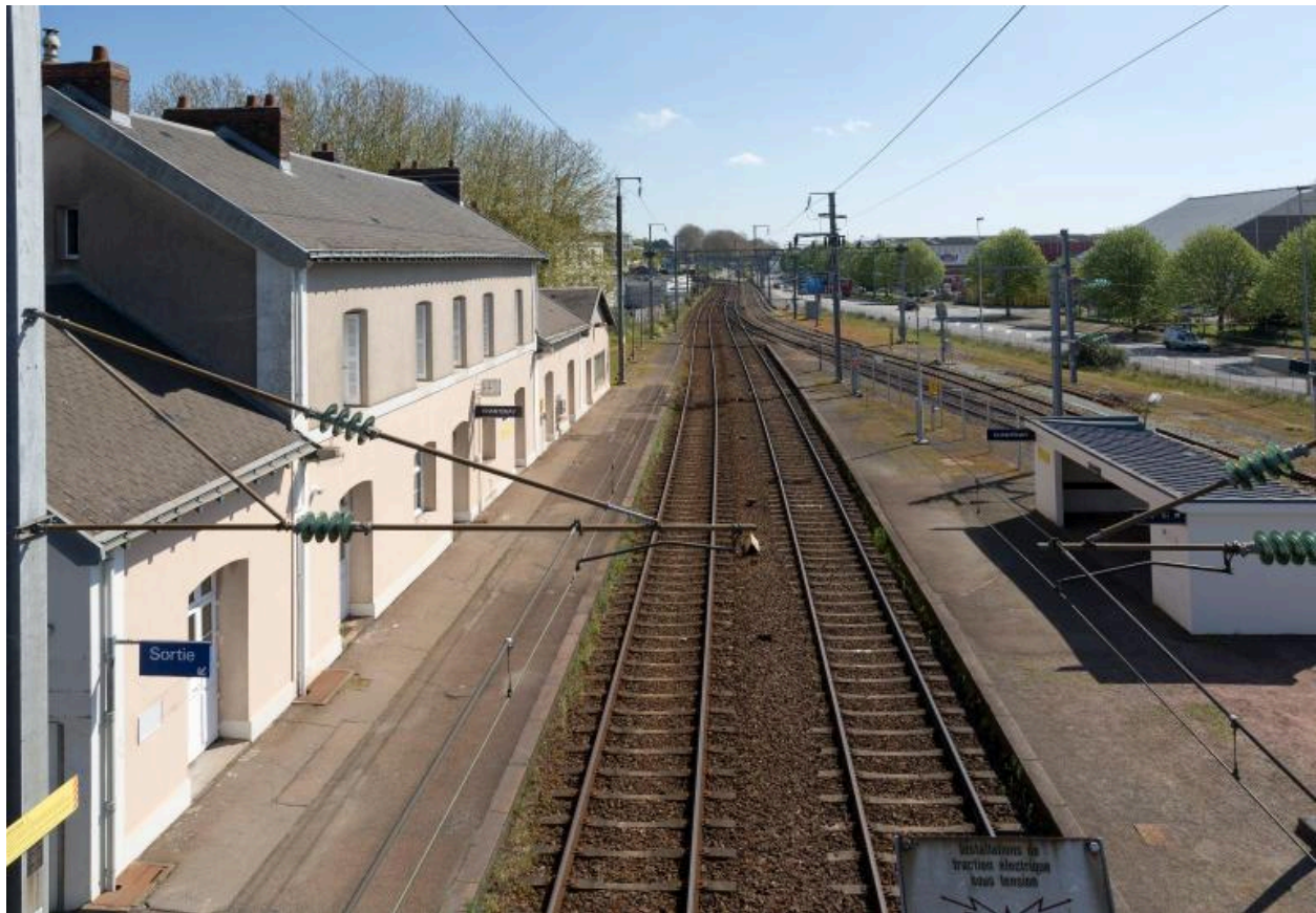
Bâtiment voyageurs, abri et voies en direction de Nantes centre.
