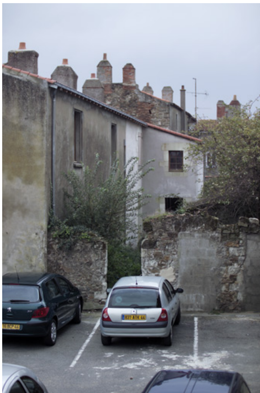
La façade postérieure de la maison n° 10, n° 12 rue de l'Hôpital depuis la rue.
