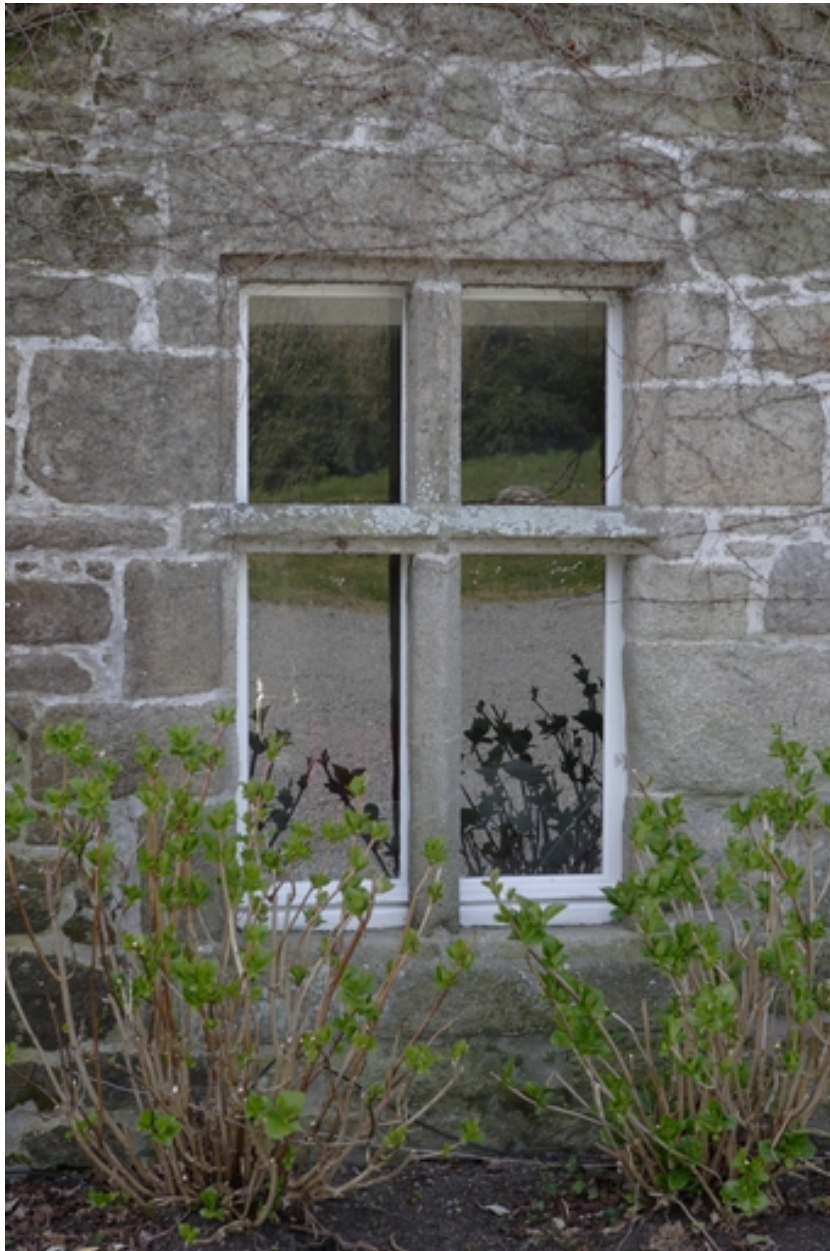
Façade nord. Rez-de-chaussée. Détail de la croisée de la salle basse.
