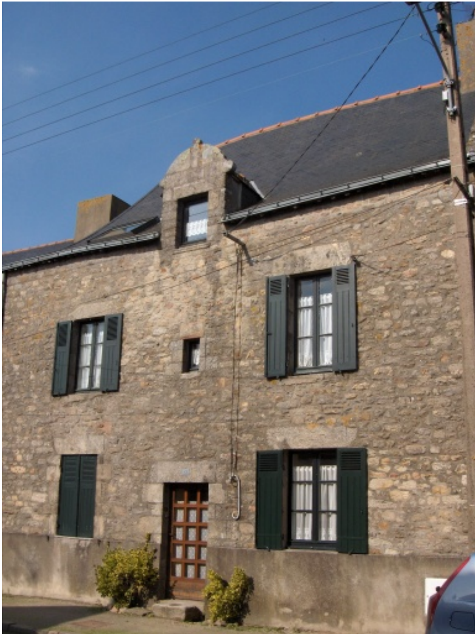
Façade, vue générale.
