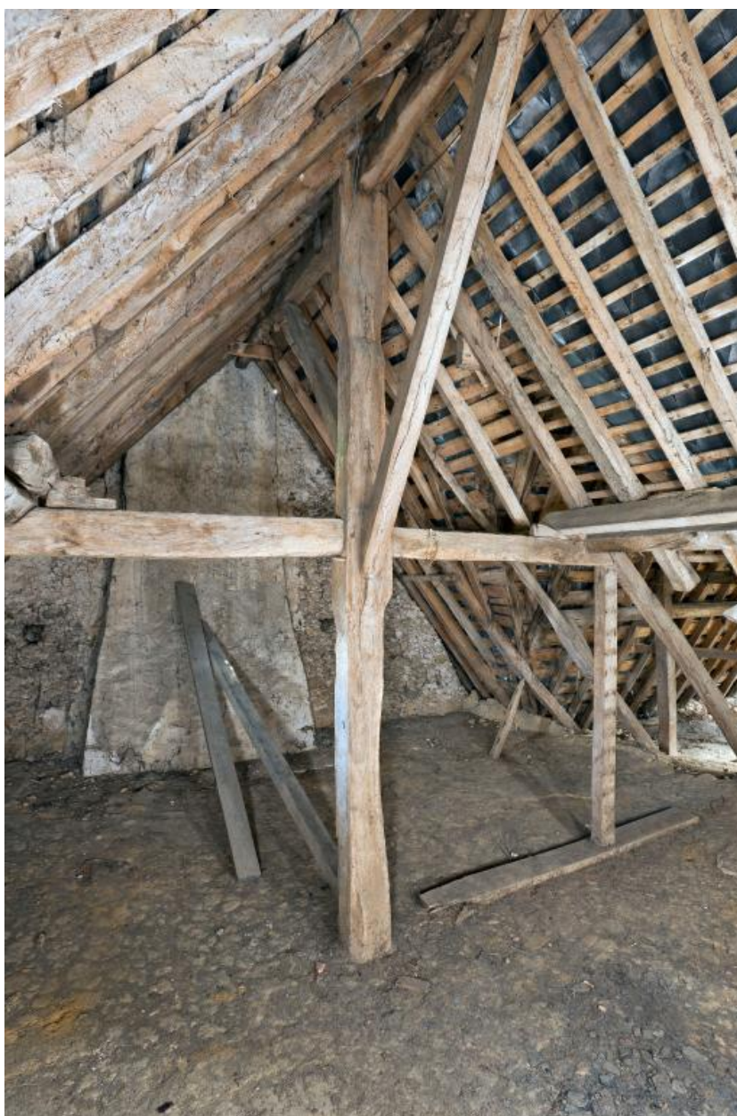
Maison 1, comble : charpente et pignon est.
