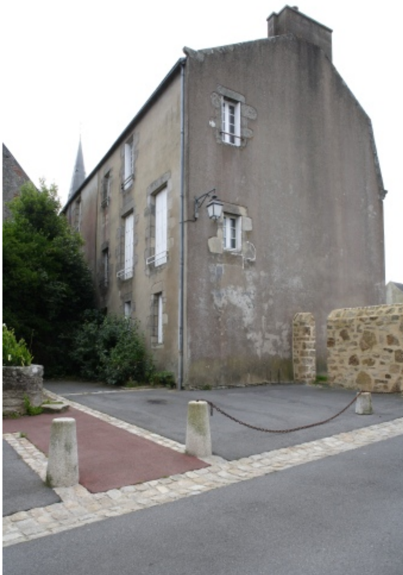
Pignon et façade postérieure.
