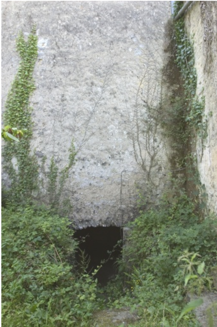
L'accès à la cave, sur la façade latérale ouest du logis.
