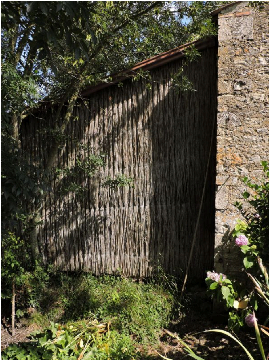
Mur pignon ouest du hangar en appentis en roseau.
