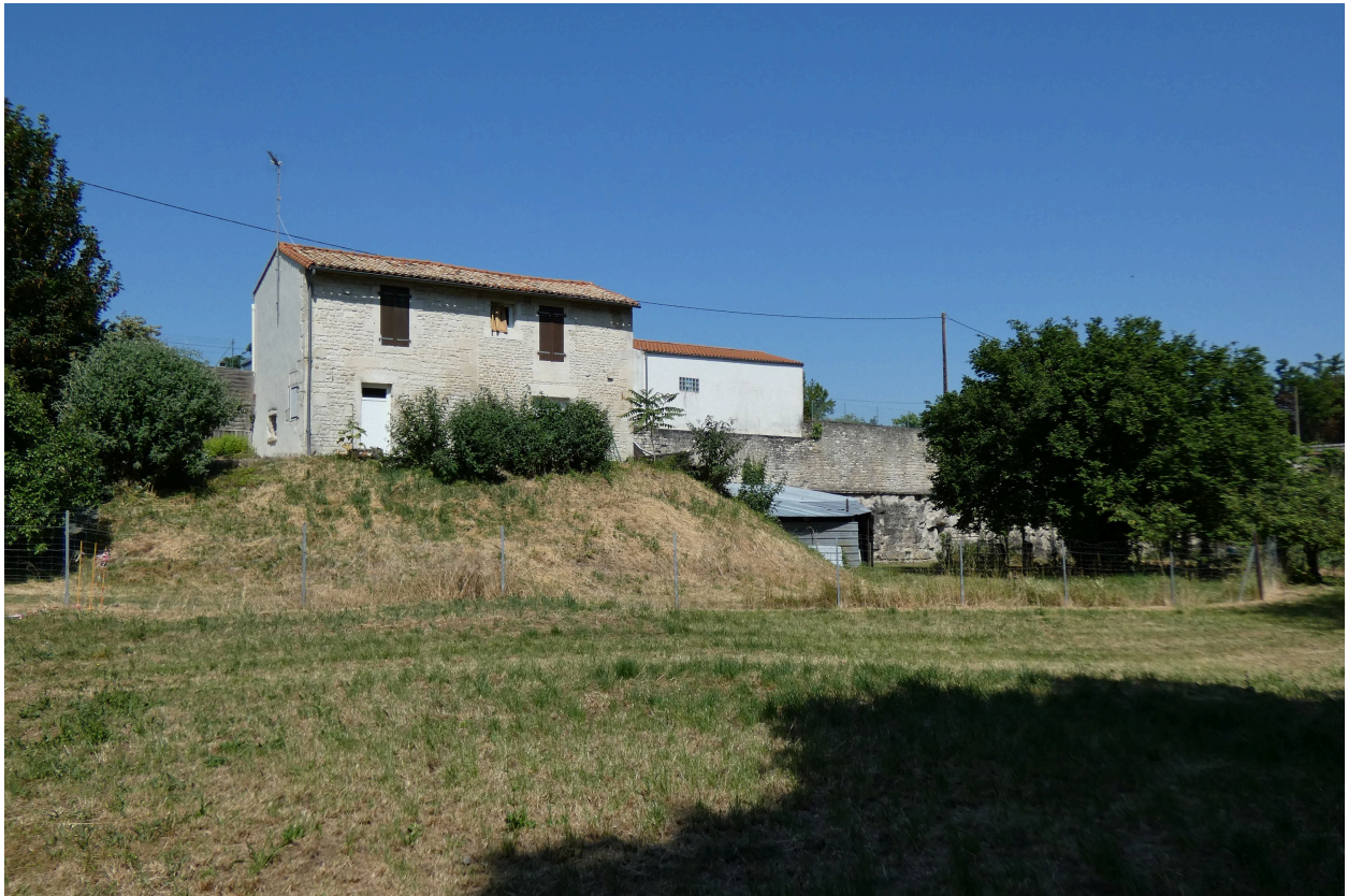
Réfectoire et bâtiment de douches sur le côté ouest de la première carrière, vu depuis le sud-est.
