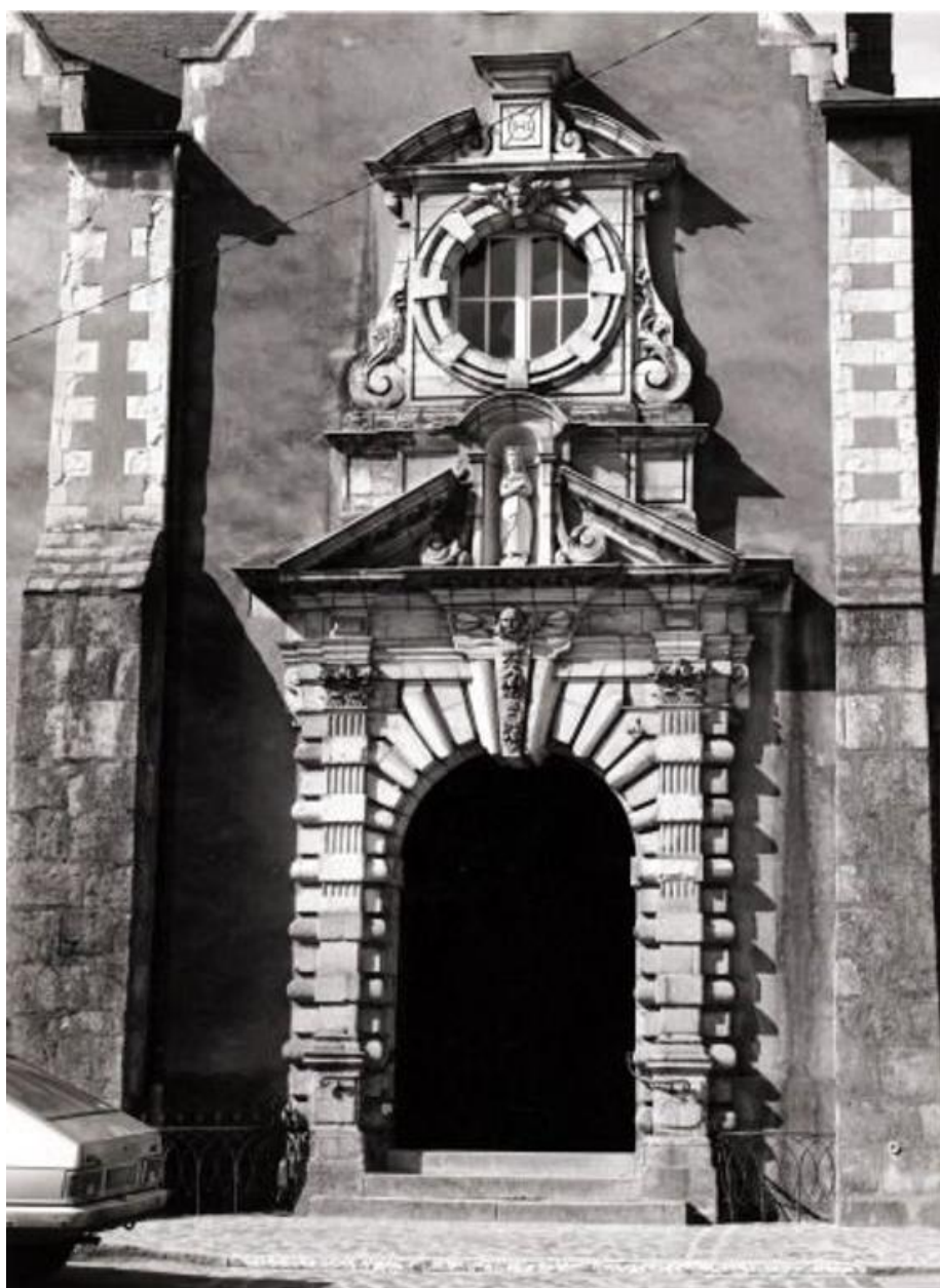
Eglise, portail : vue d'ensemble.
