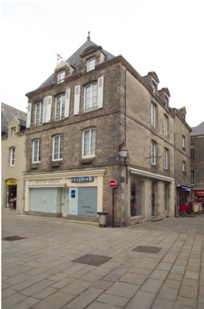
Vue générale vers le Nord-Est.
