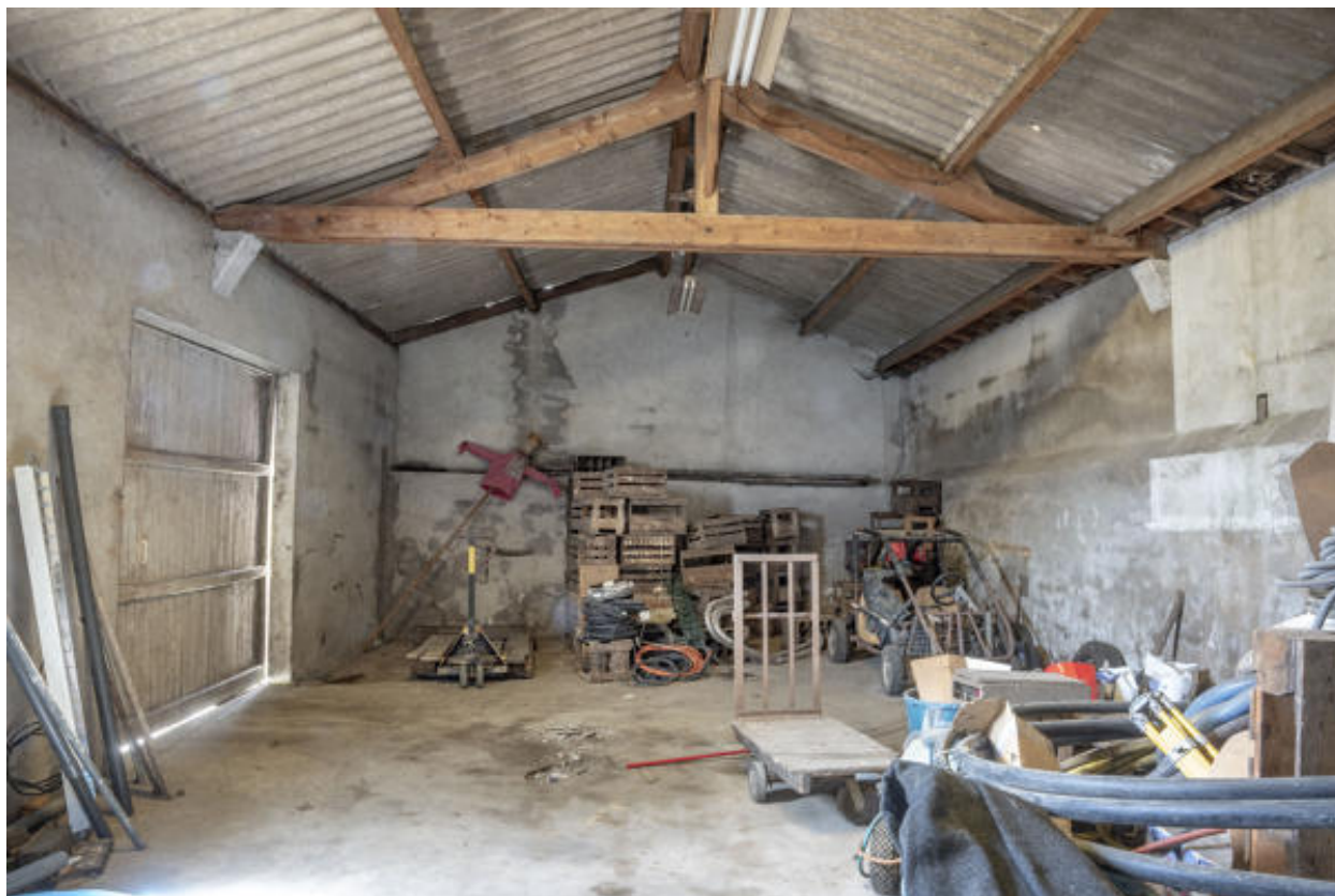
Aile nord du bâtiment, extrémité ouest.
