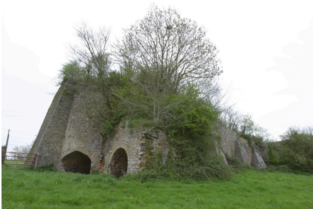
Le four vu depuis le sud-ouest.
