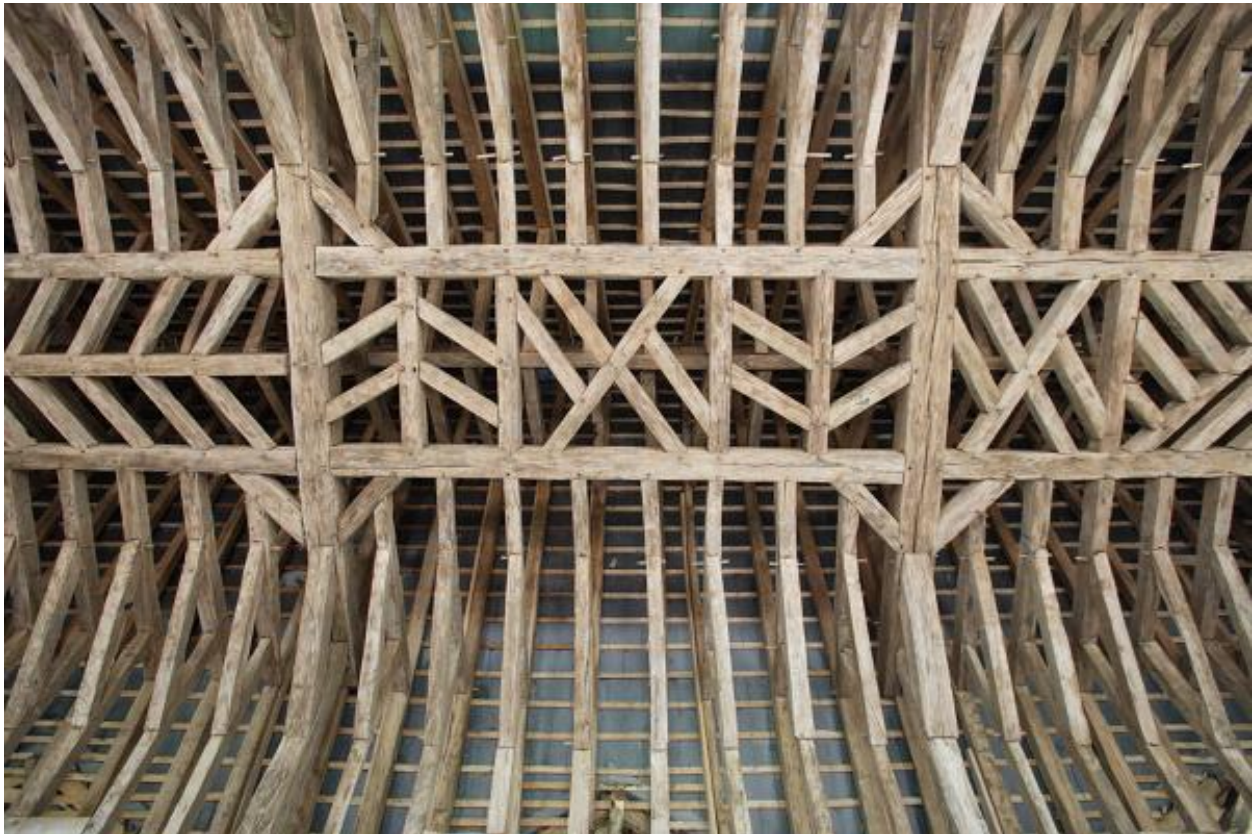
Le grand comble et sa charpente, fermes et sous-faîtage.
