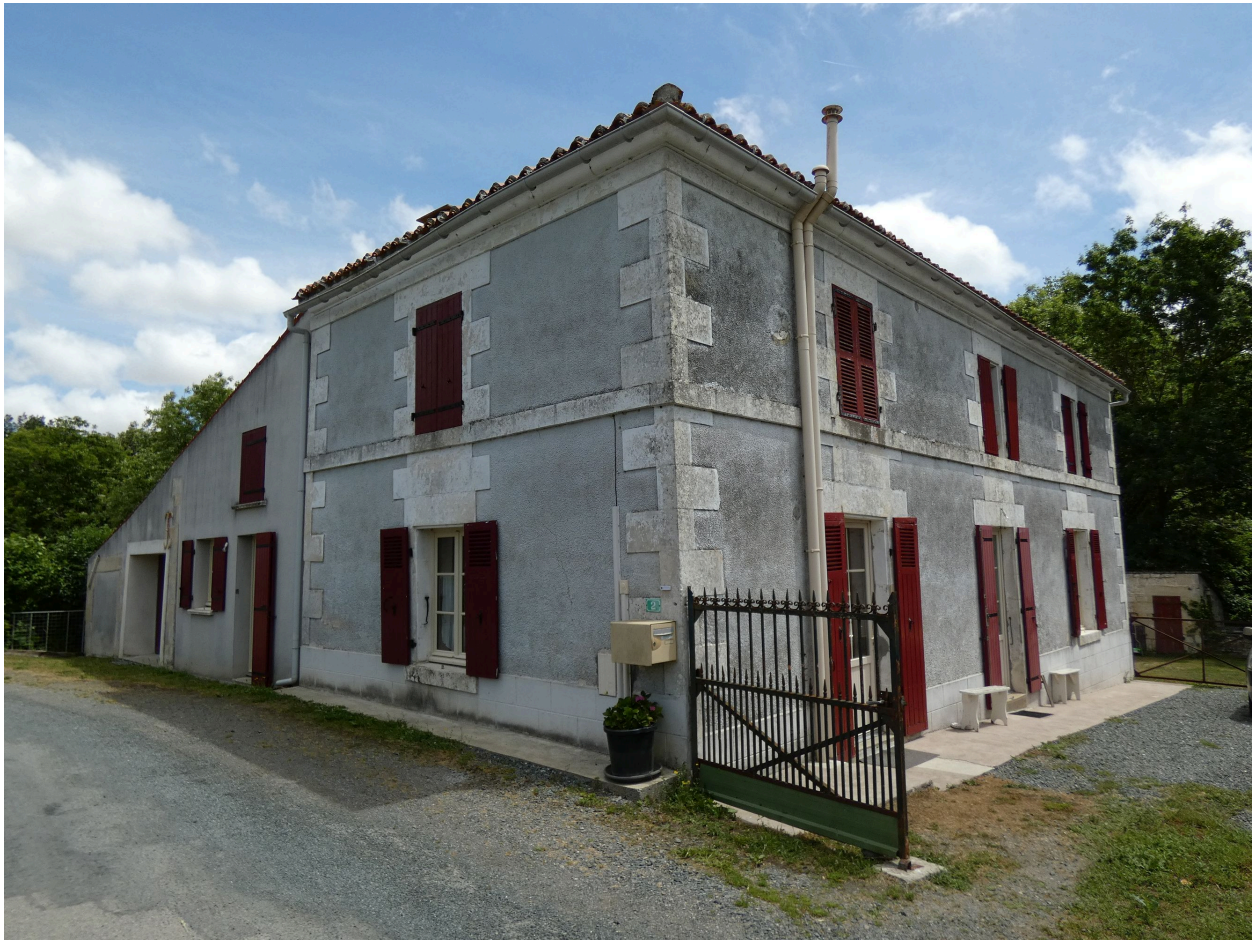
L'ancienne ferme vue depuis l'ouest.
