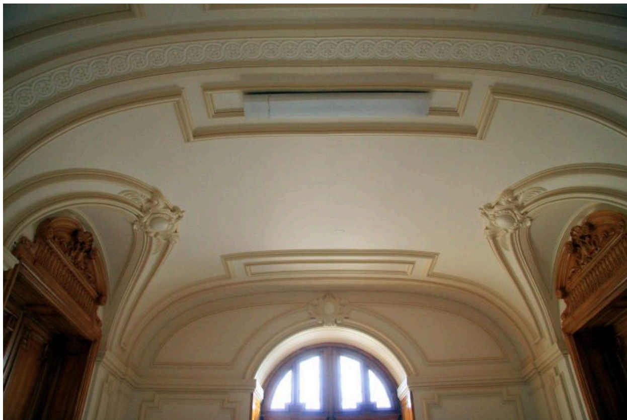
Le vestibule : le plafond.
