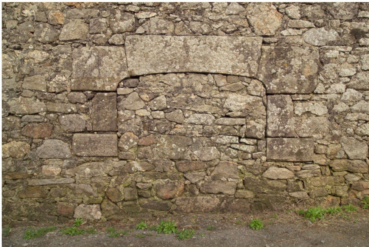
Ouverture murée du mur de clôture.
