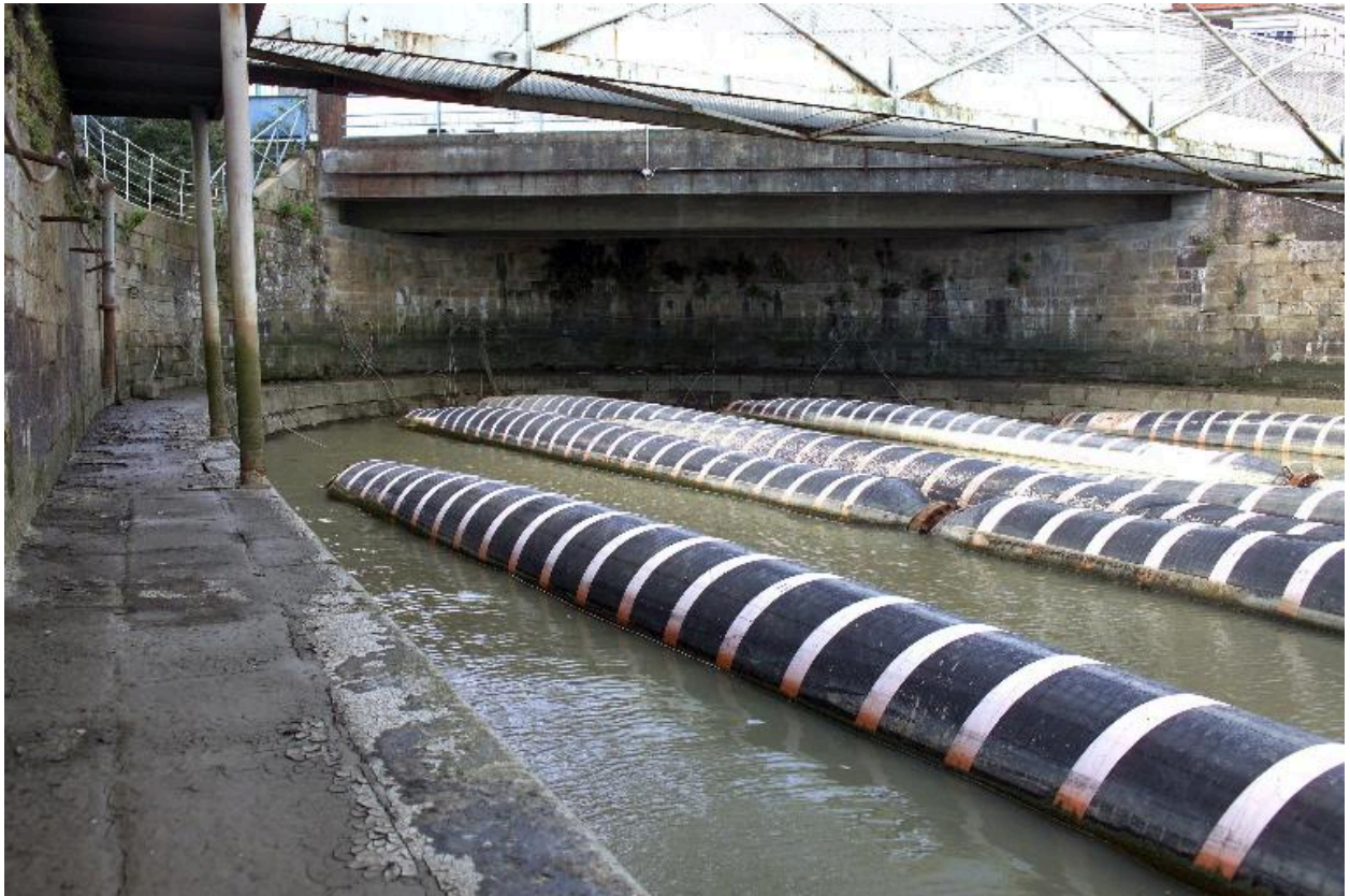
Le bassin de carénage, vue du fond situé sous la route.
