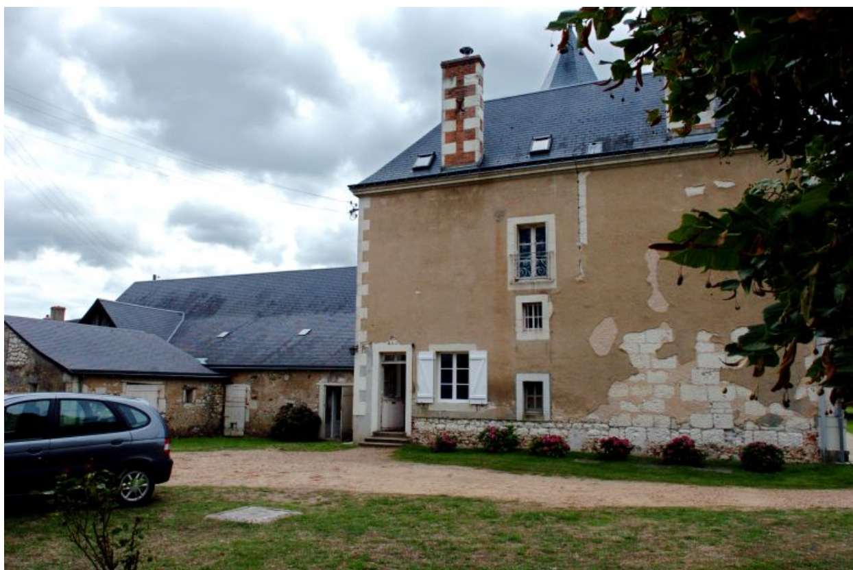
Vue d'ensemble de la façade postérieure.
