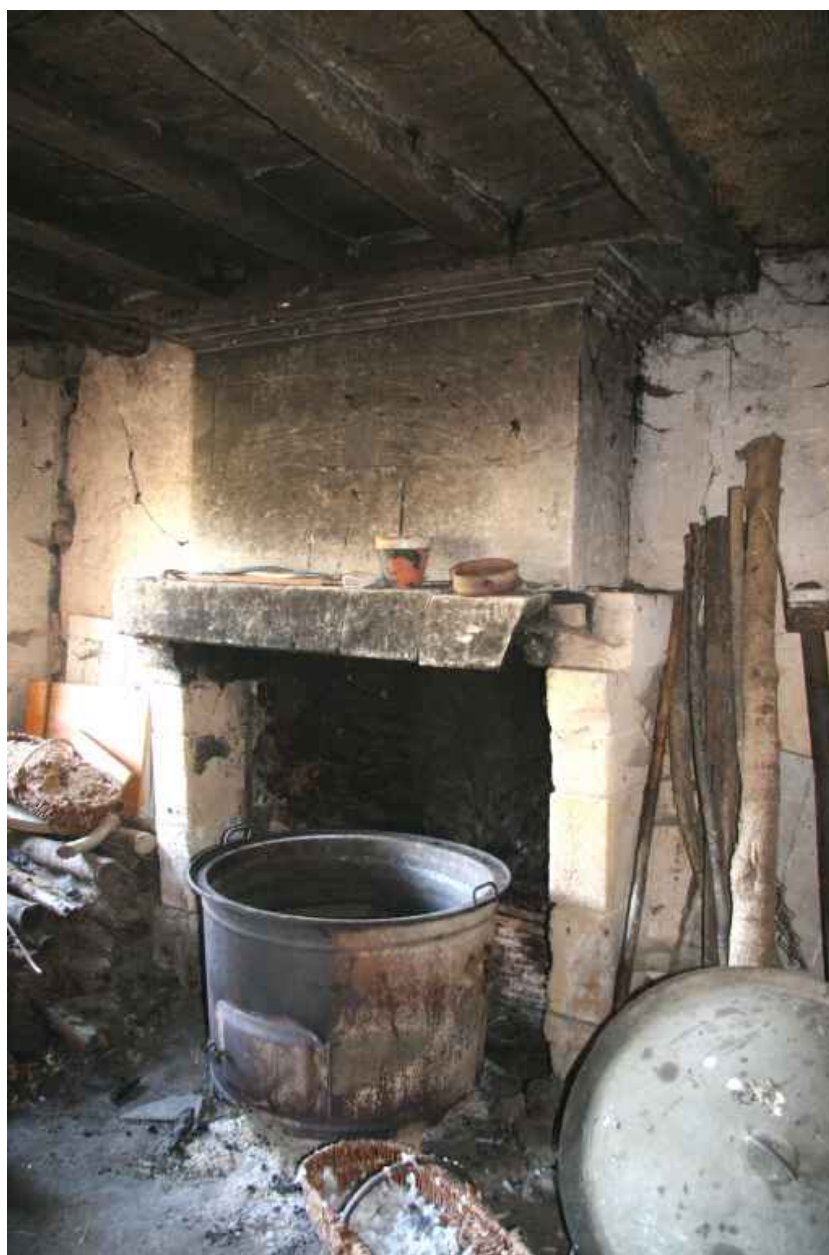
Deuxième maison : cheminée.
