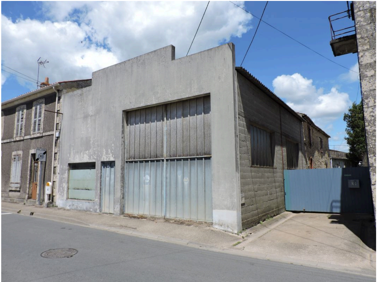
L'atelier du milieu du 20e siècle vu depuis le sud.
