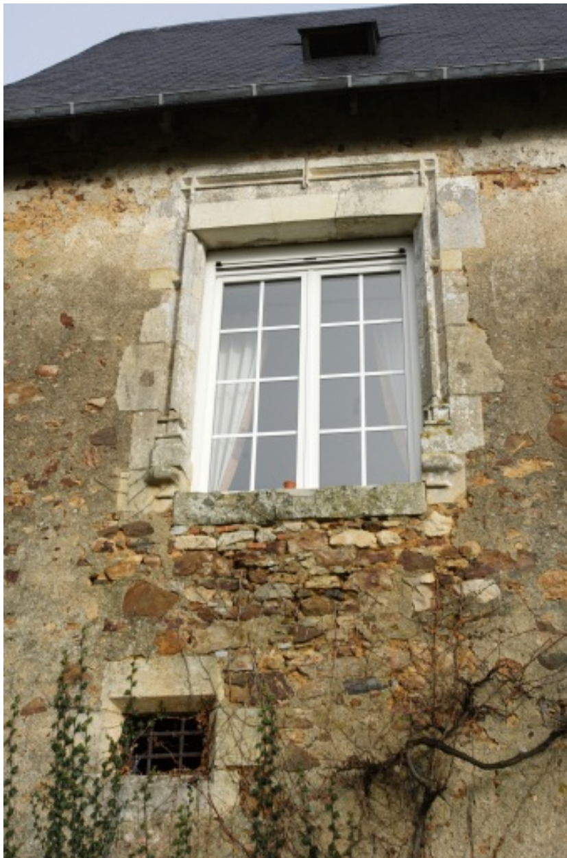
Le logis, corps principal, façade sud, 2e niveau : fenêtre gauche.
