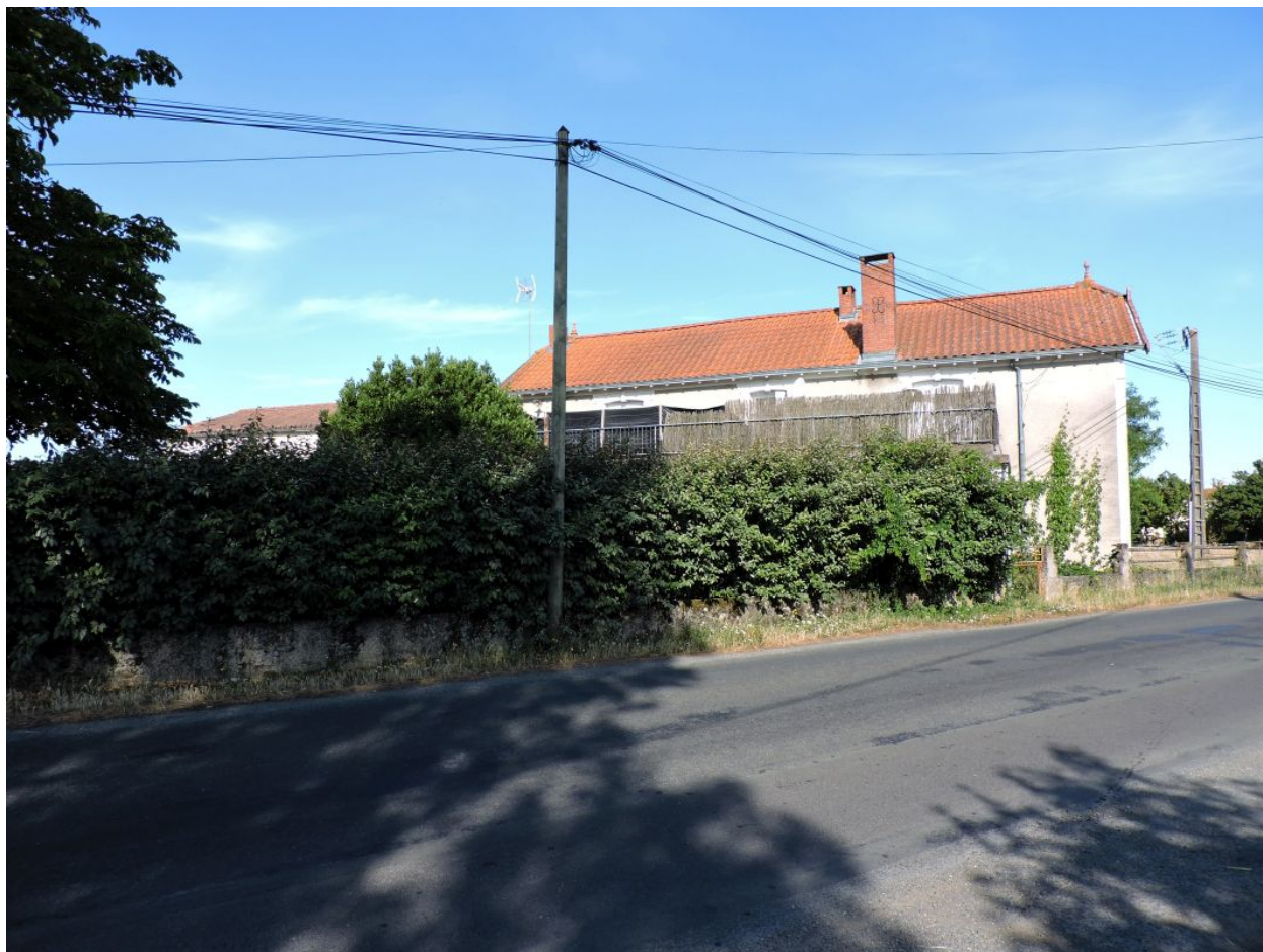
Le logis vu depuis l'est.
