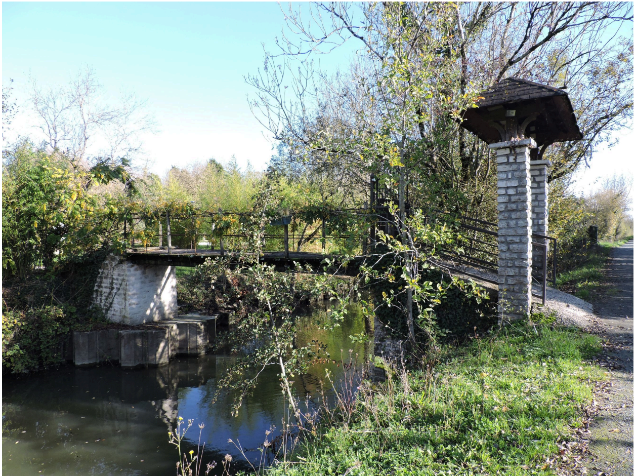
La passerelle sur la rigole de Bourneau vue depuis l'ouest.
