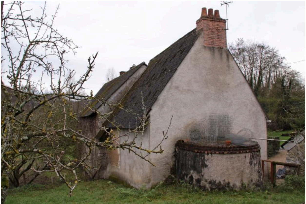
Maison 1, pignon : four à pain.
