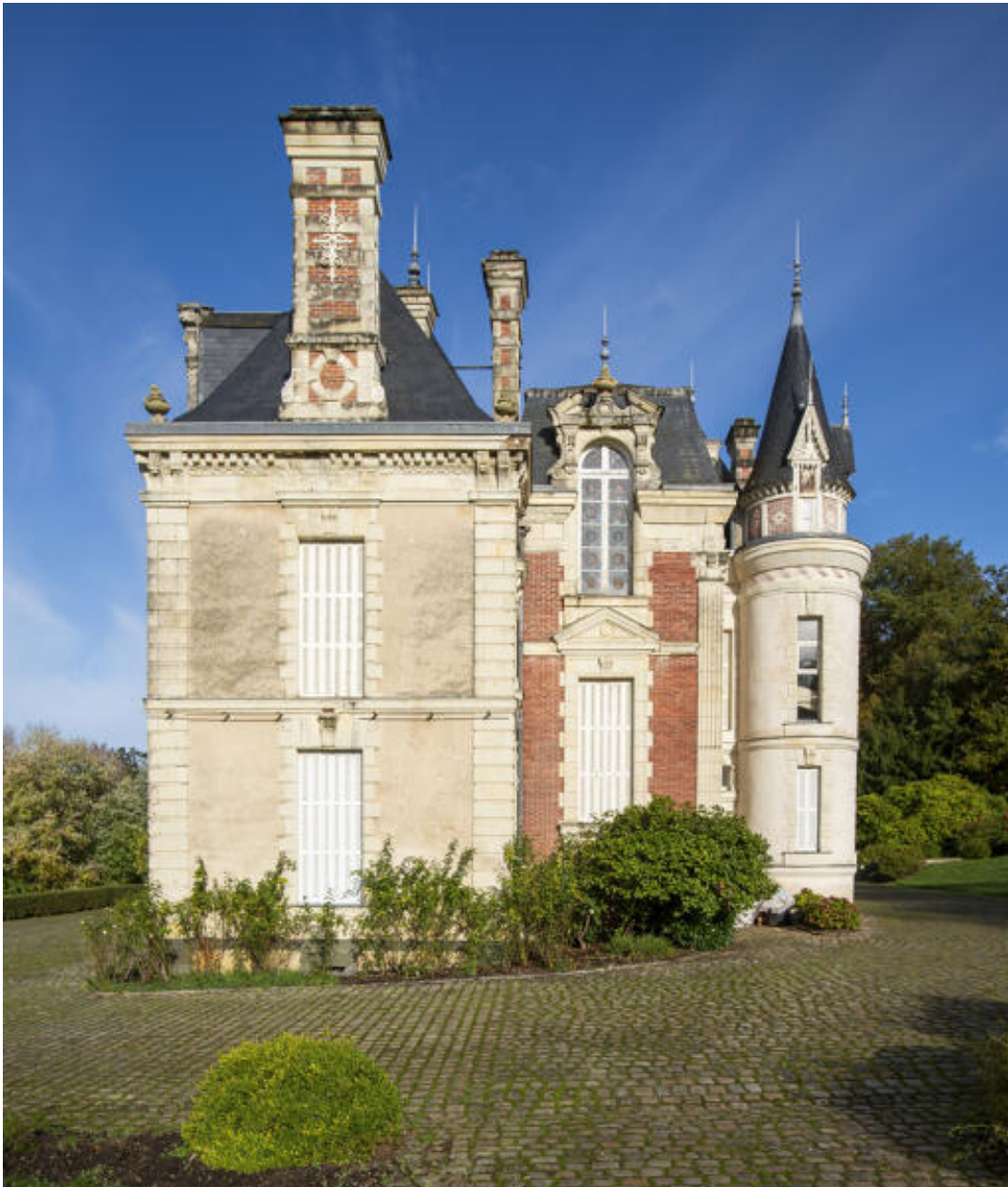
L'élévation latérale sud.
