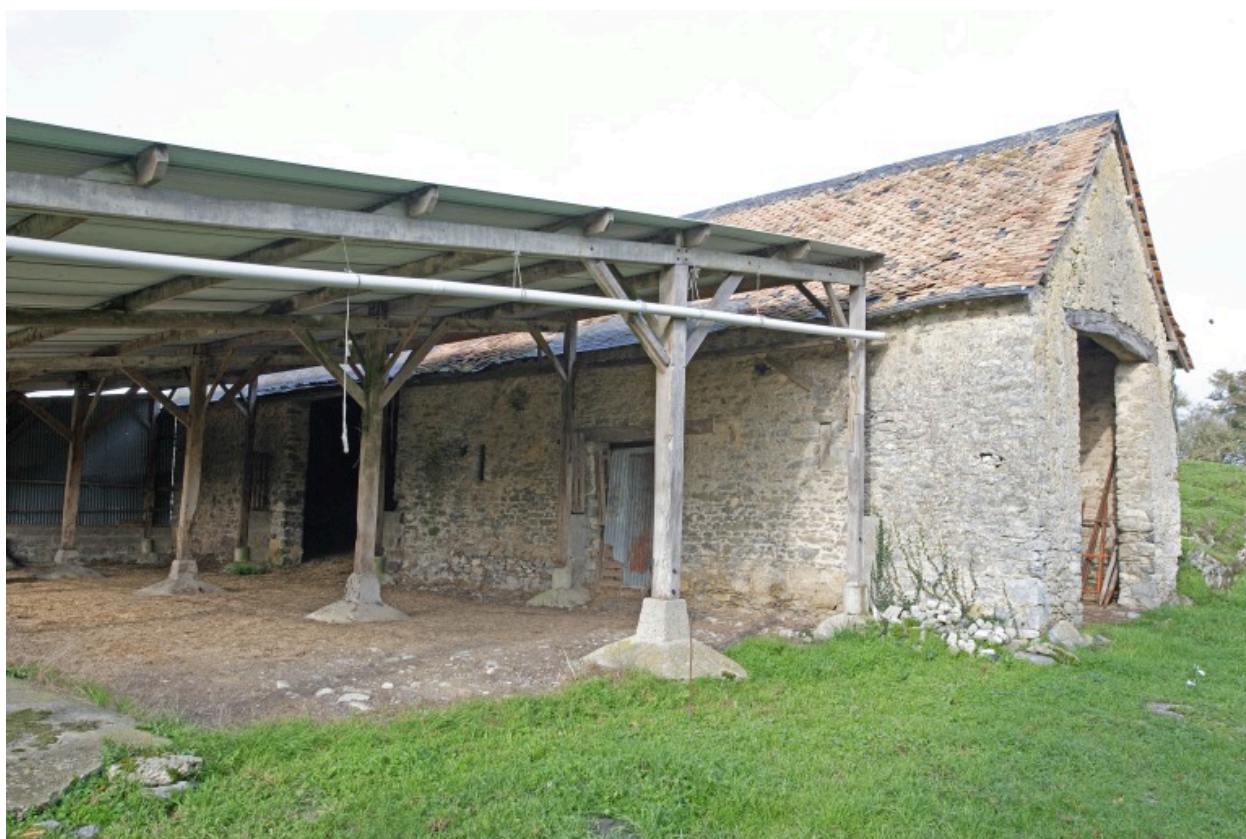
La remise vue depuis le sud-est.
