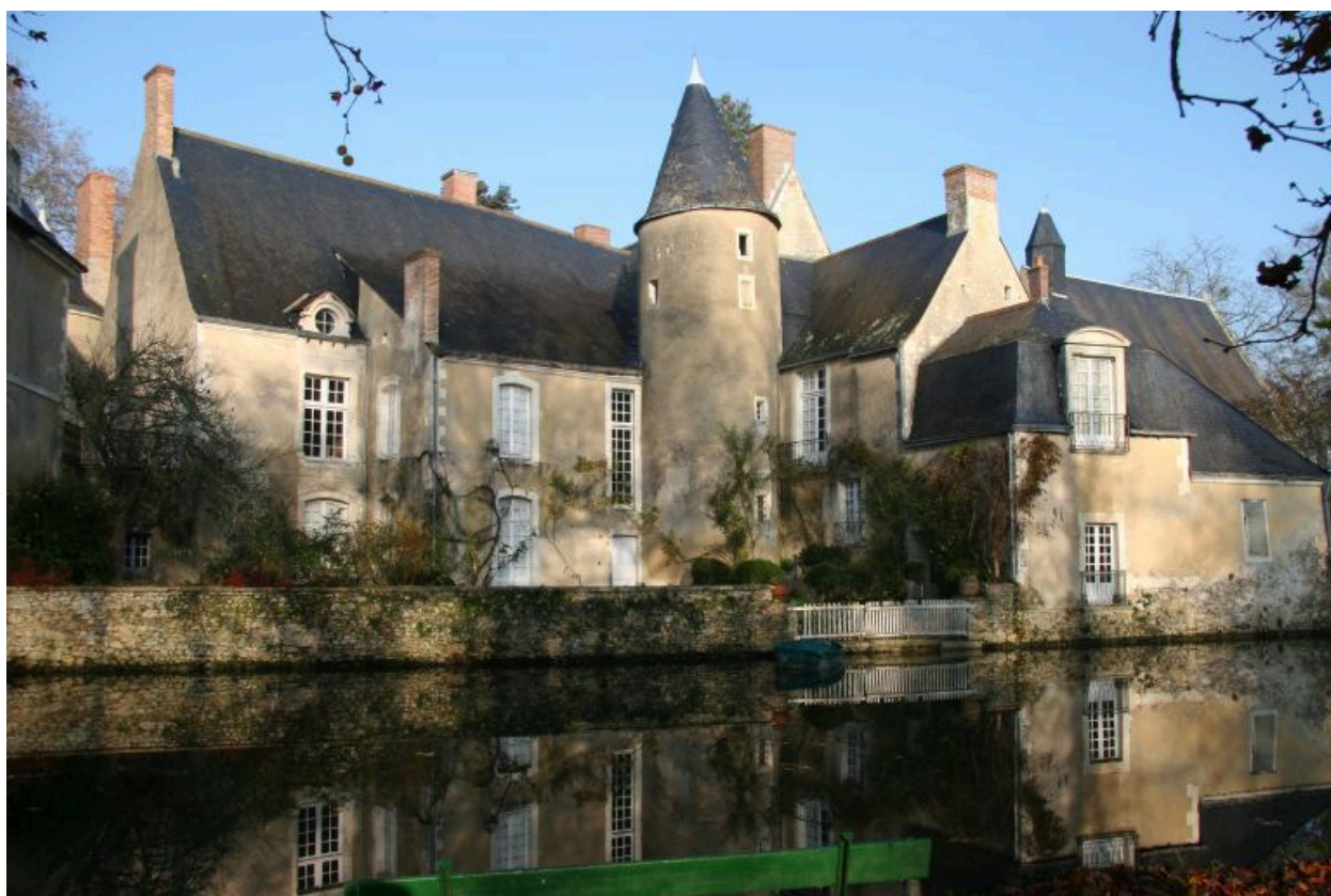
Le logis vu depuis la douve sud.
