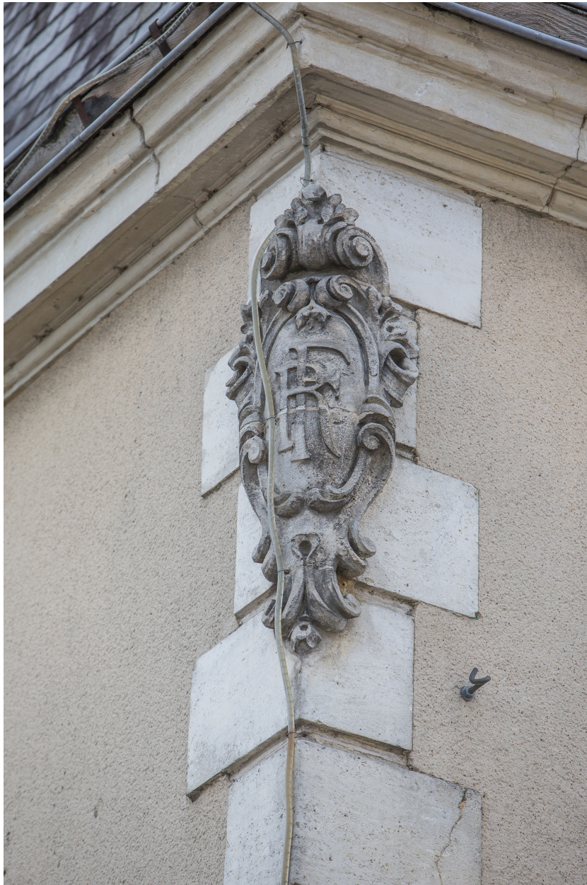
Un détail de la façade principale, un médaillon.
