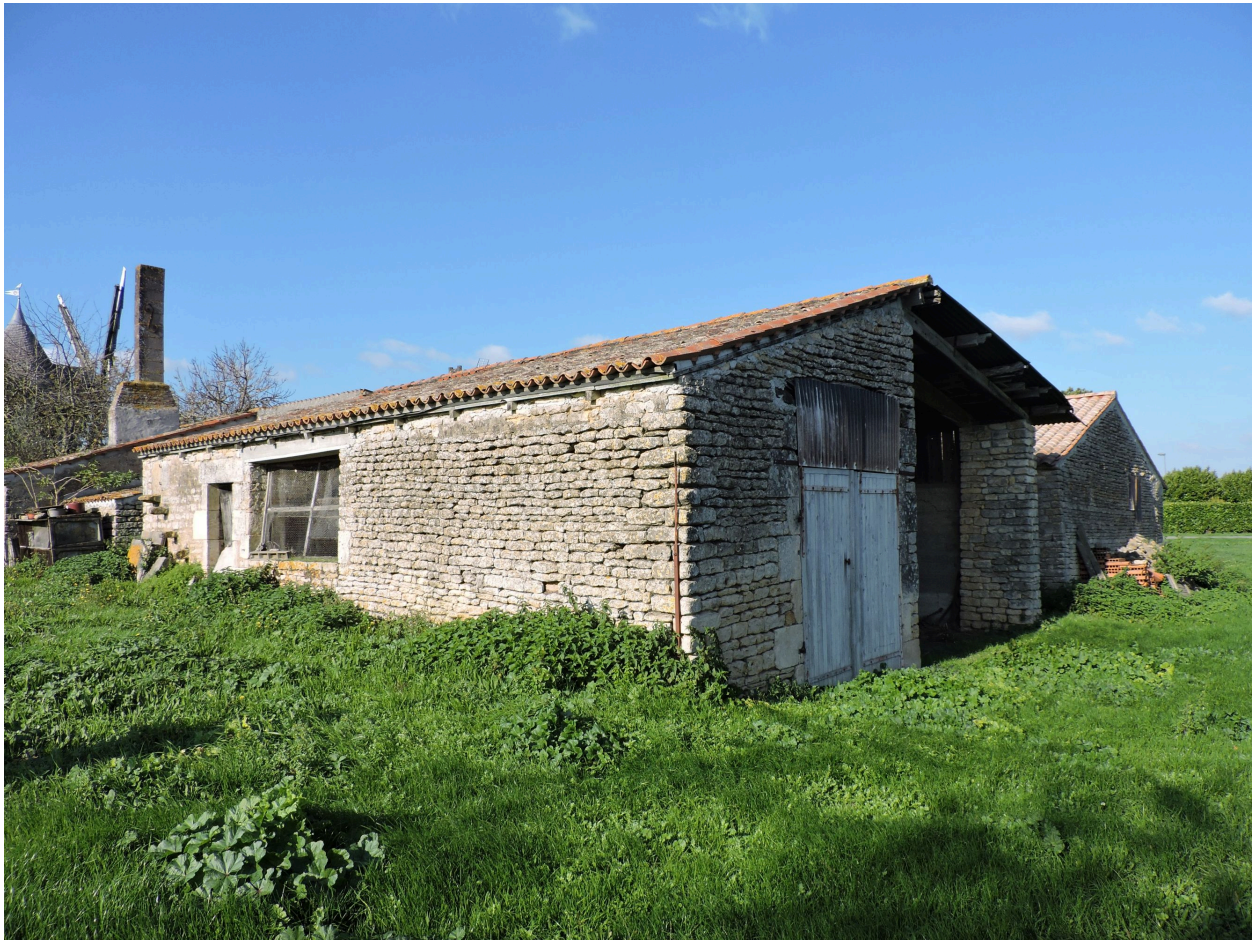
Poulailler et hangar au sud-est du logis, vus depuis le sud.
