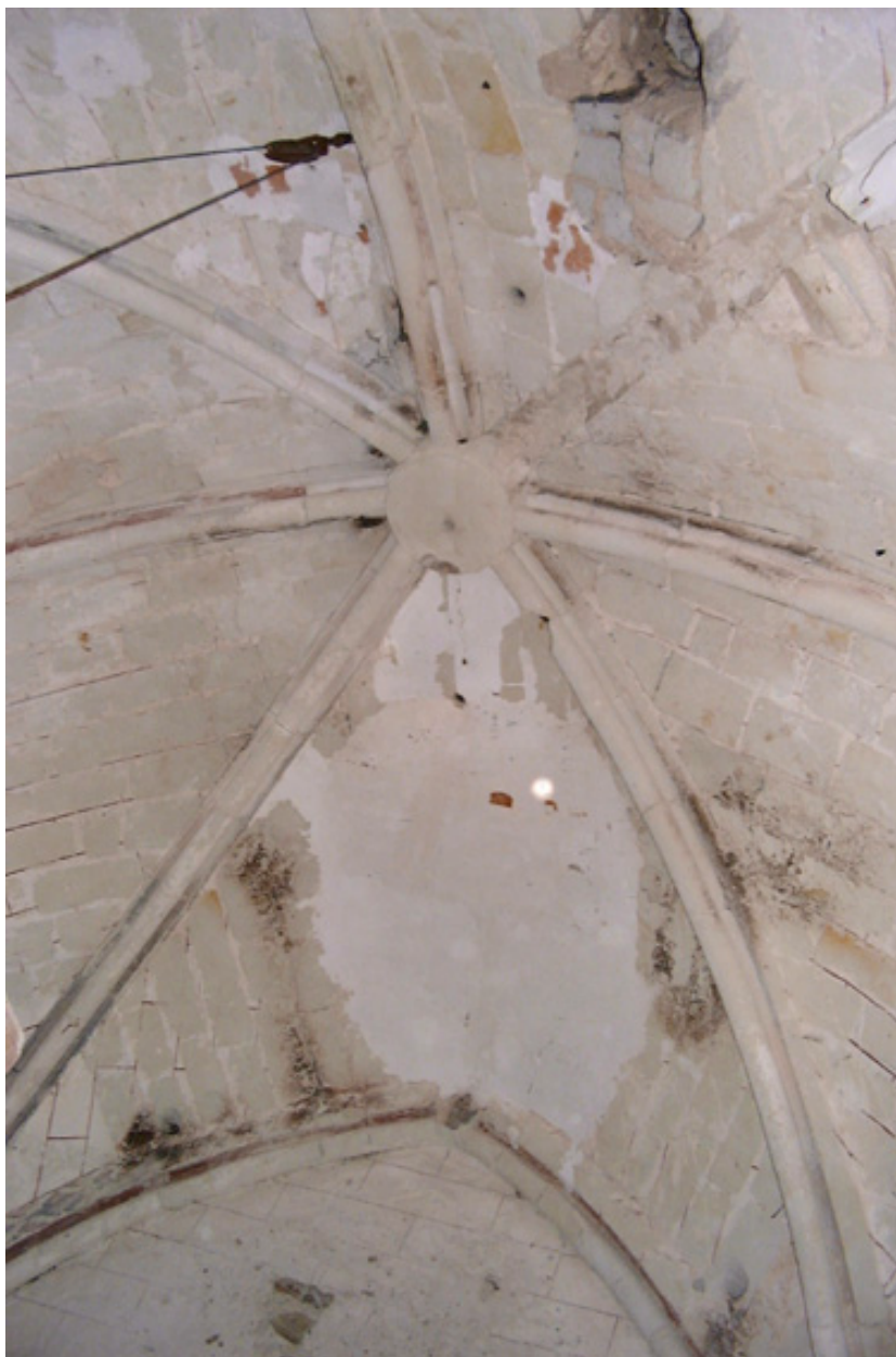
Tour de clocher : détail de la voûte.
