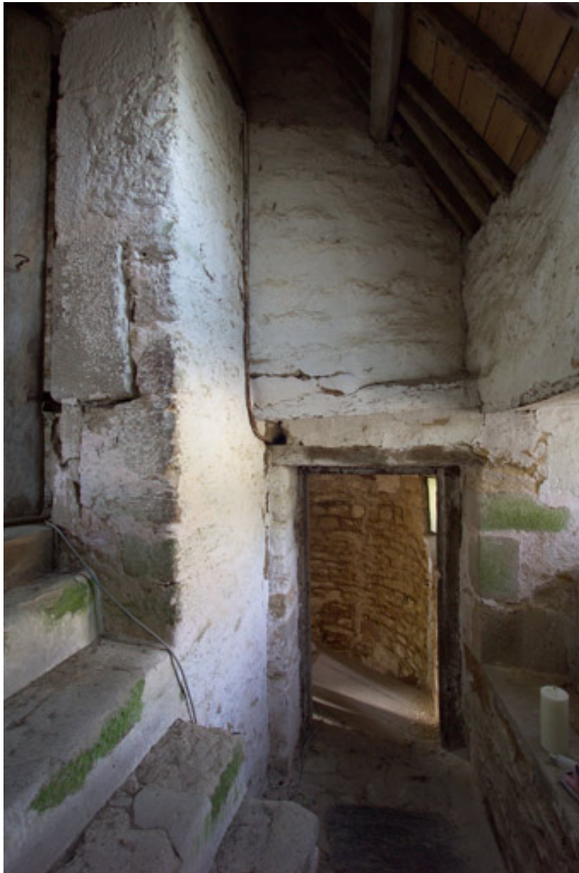
Vue intérieure de la tour.
