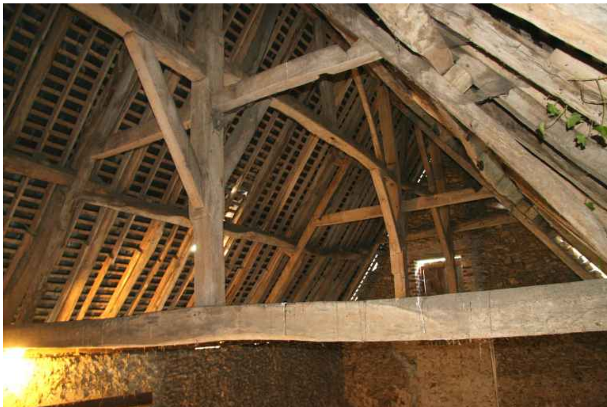
La grange étable : 1er type de charpente modifié.
