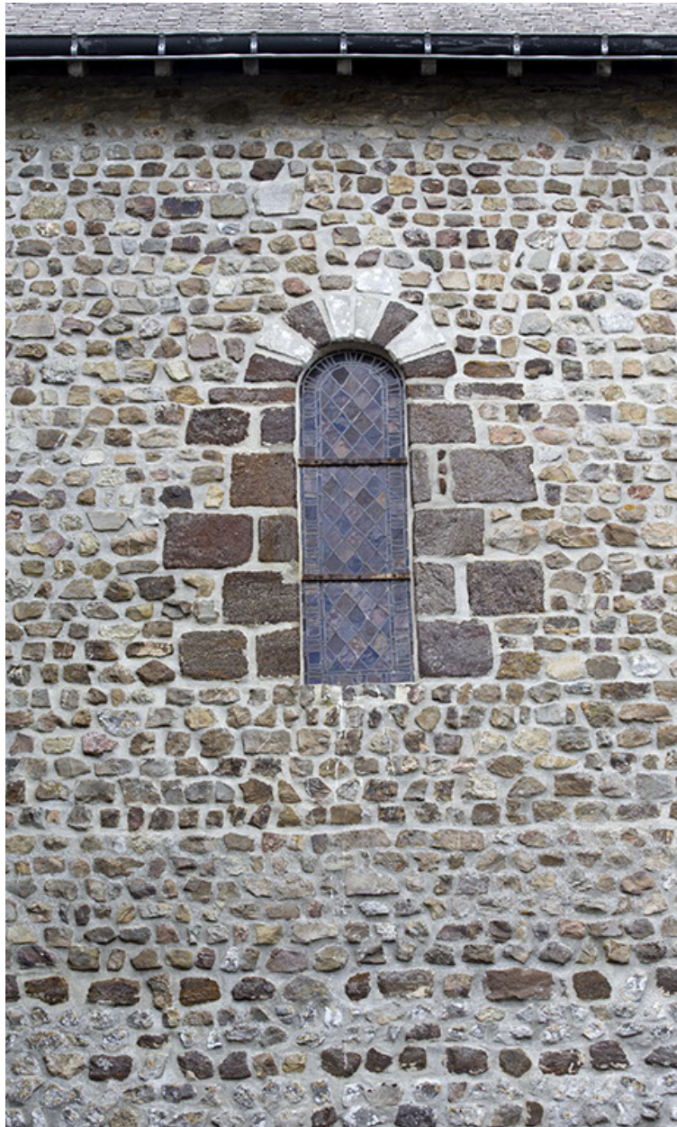
Baie est du mur nord de la nef.
