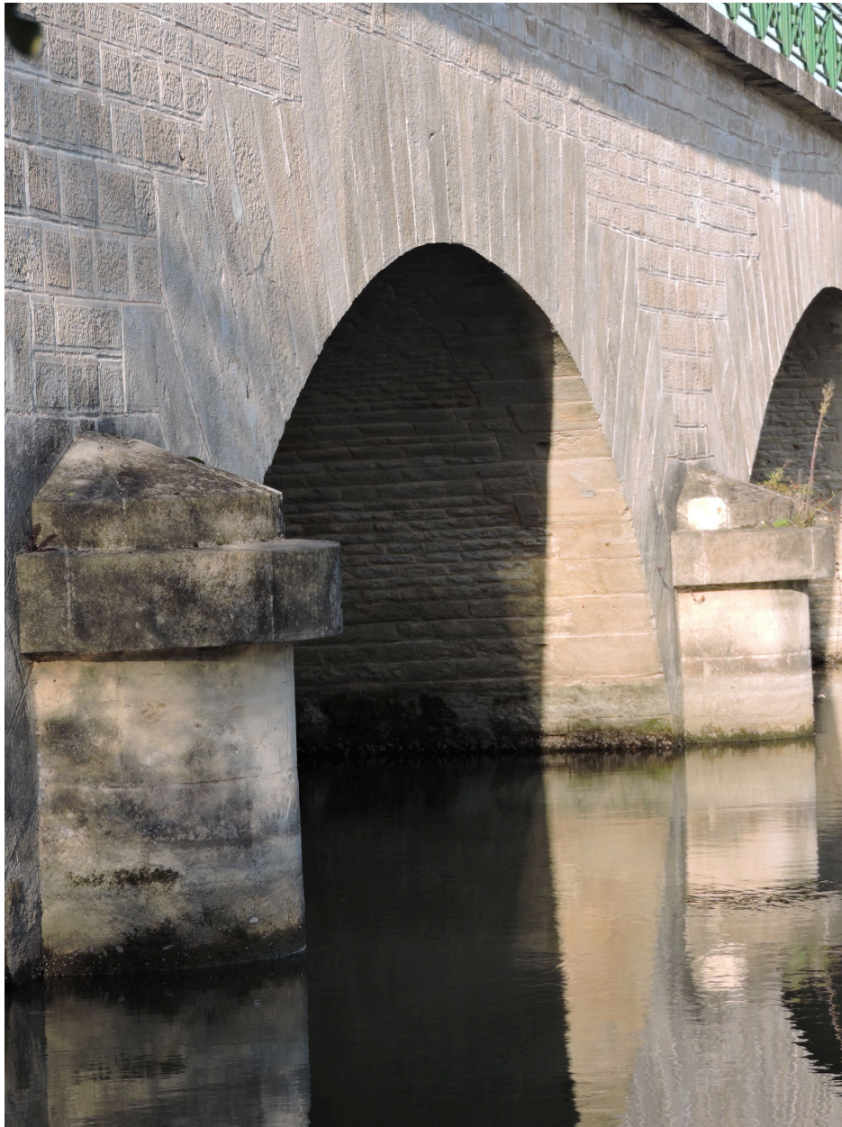
Détail du grand pont côté amont : l'arche centrale et les musoirs.
