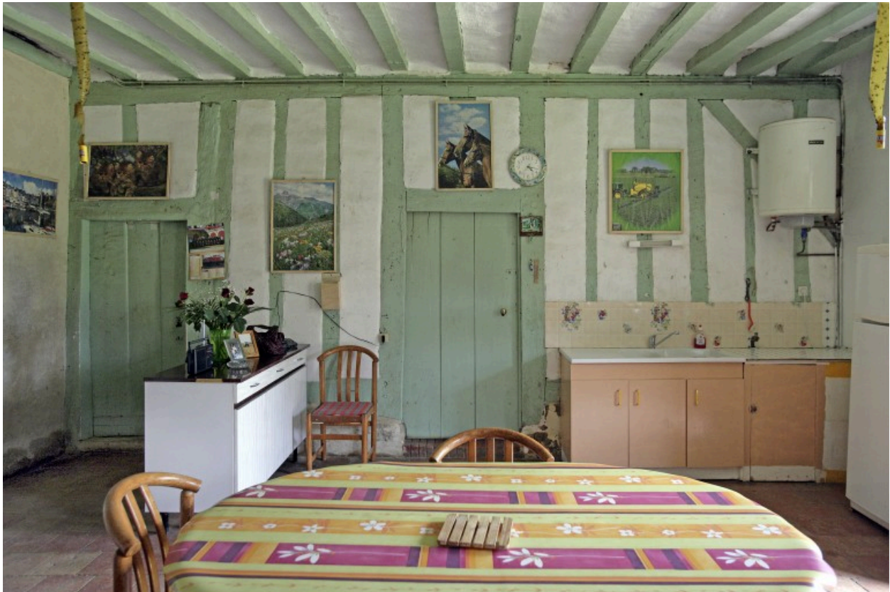
Logis, intérieur : cloison de refend avec portes vers la chambre froide et le cellier.
