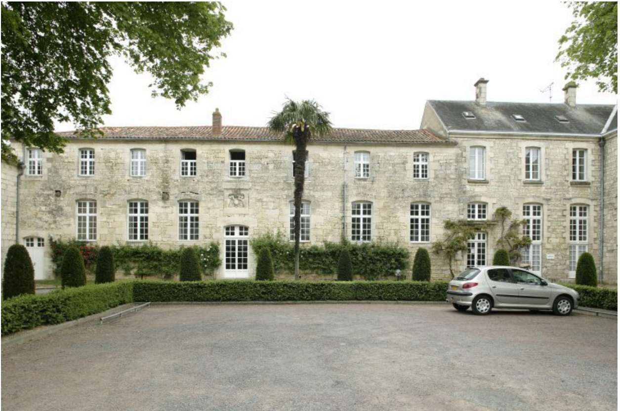
Façade sur cour de l'aile est (pavillon Saint-Côme et corps de bâtiment en prolongement).
