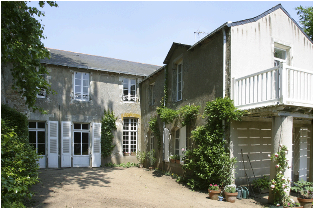
Vue de la partie adressée n° 50 quai Chassagne depuis le jardin.
