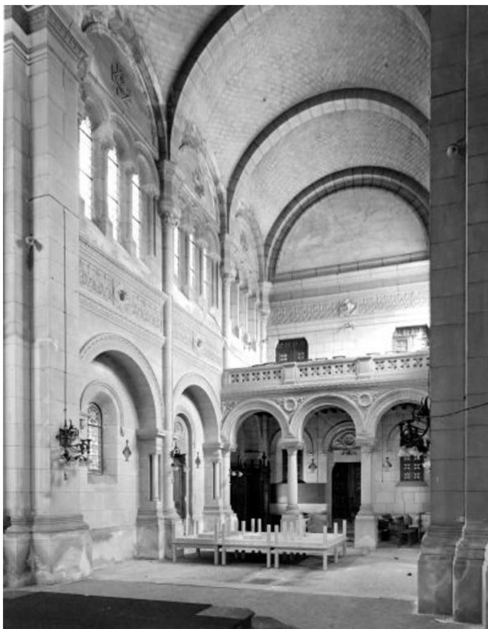
Vue de la nef depuis le chœur.
