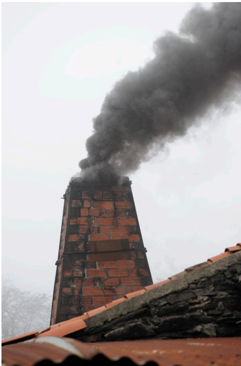
Cheminée du four à bois.
