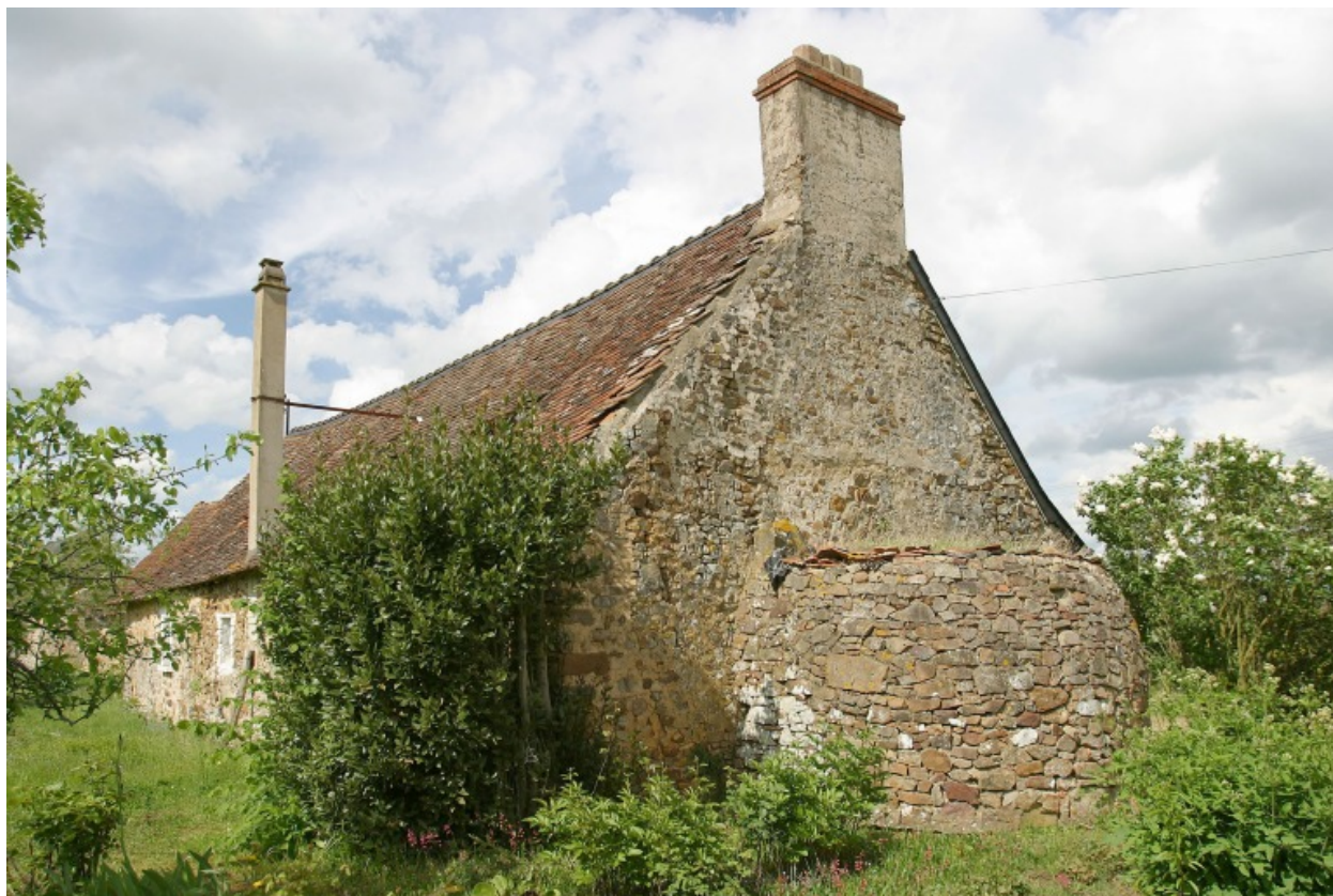
Le logis 1 : façade arrière, pignon et four à pain vus depuis le sud-ouest.
