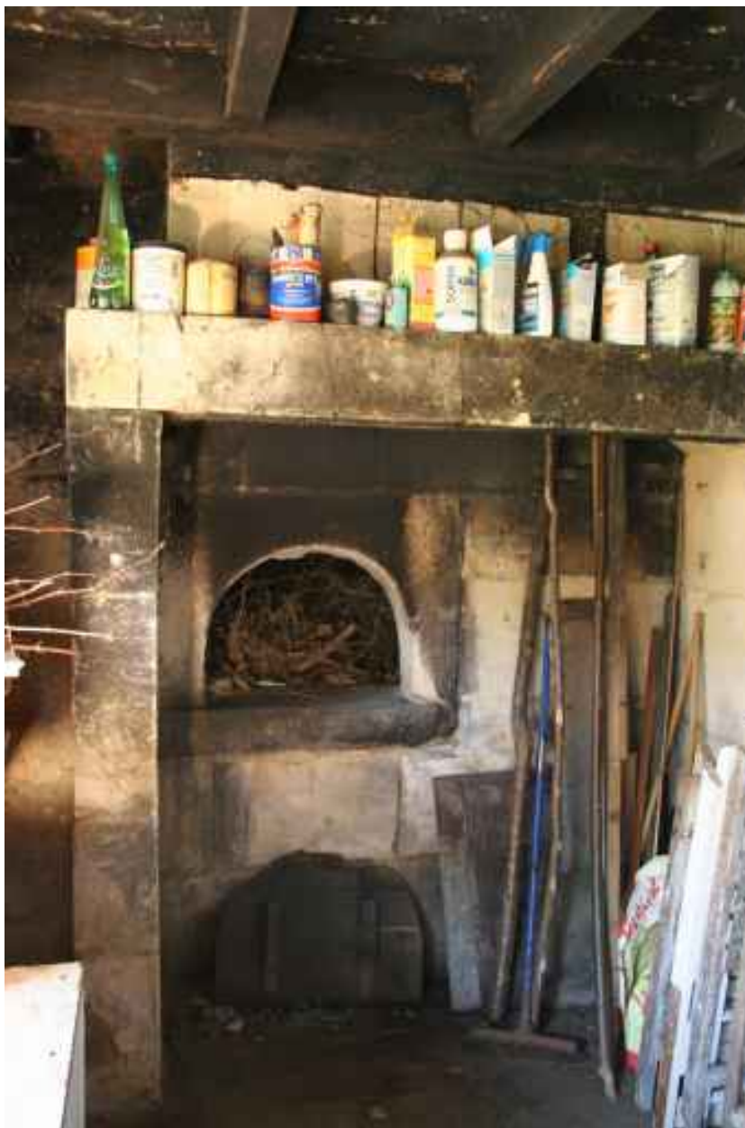
Maison 2, la boulangerie : la cheminée.
