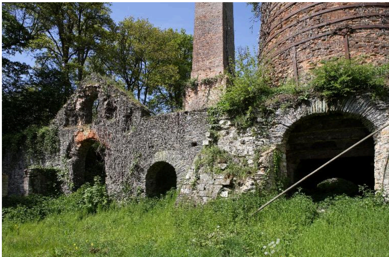
Entrée du haut-fourneau.
