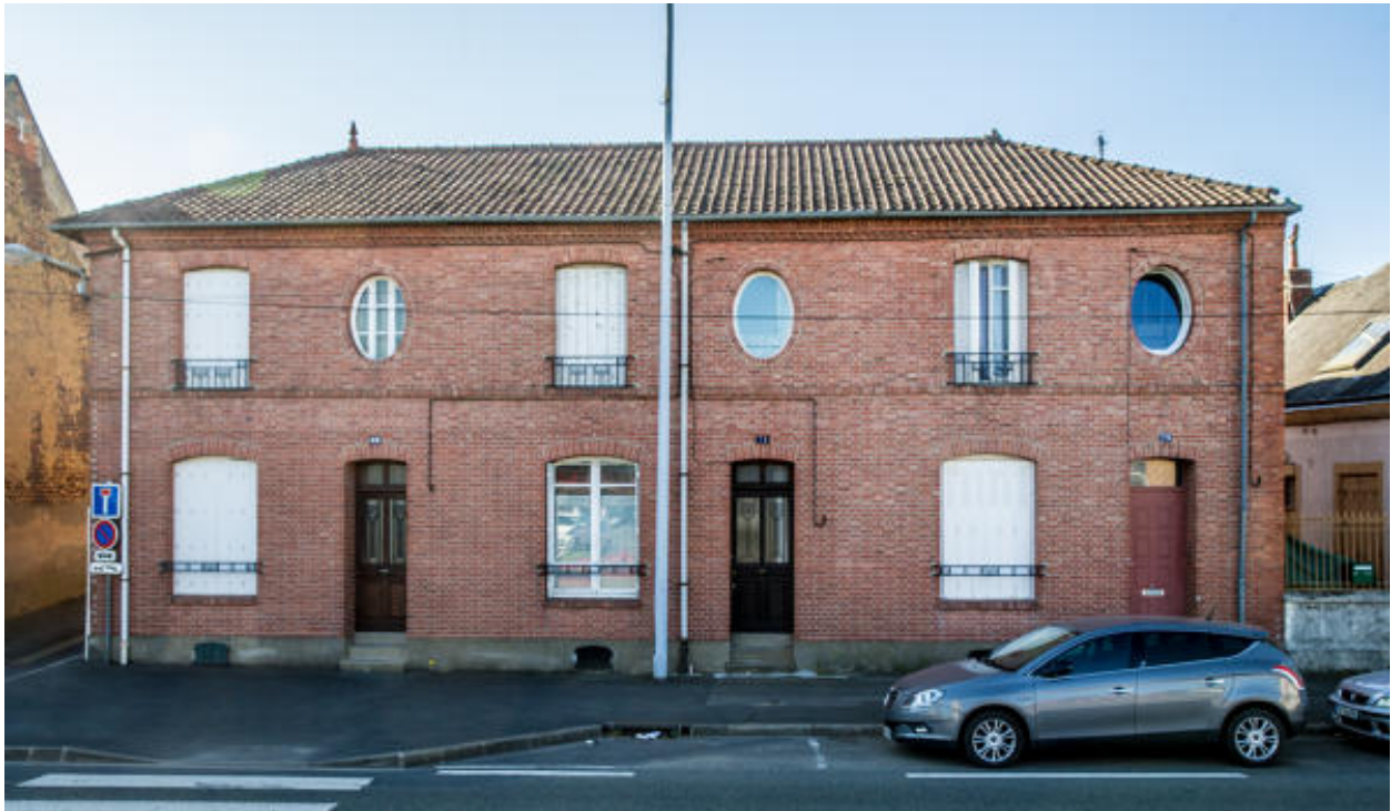
Vue des maisons de briques avenue Olivier-Heuzé.
