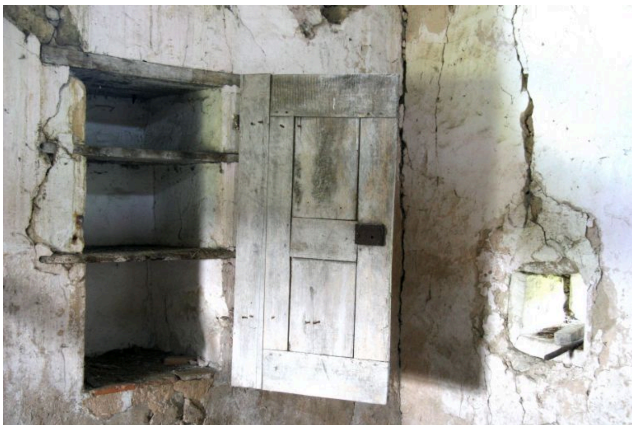
Placard dans le mur ouvert.
