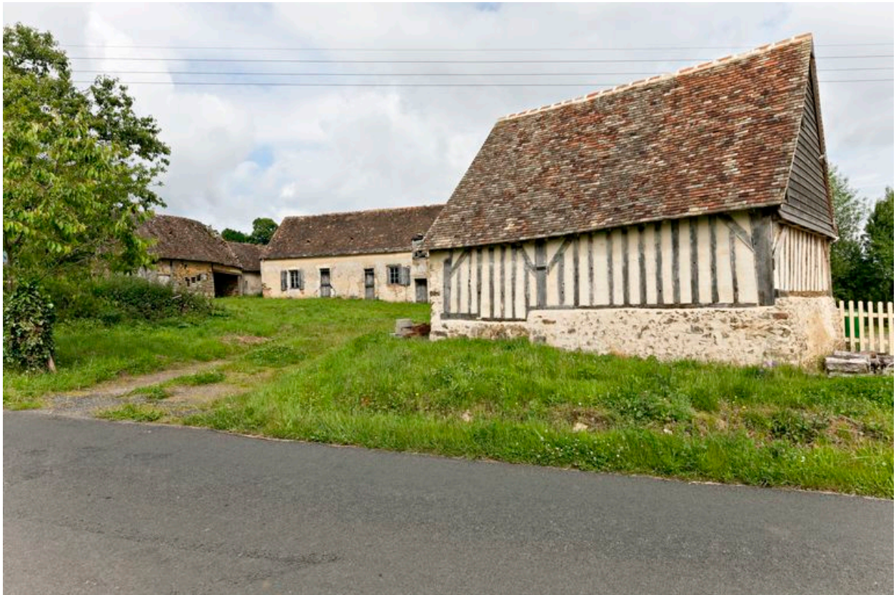
La ferme 2 et l'étable de la ferme 1, vues depuis l'est.
